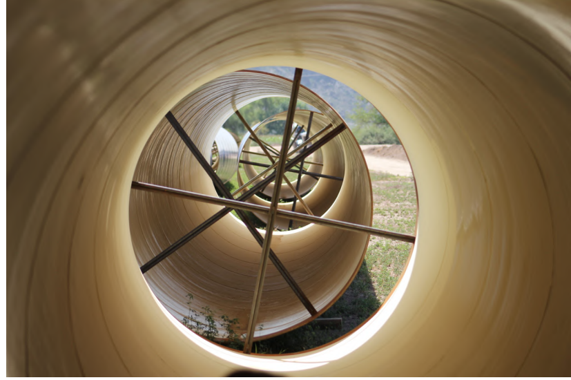
Comarca Lagunera. Proyecto Planta Potabilizadora, Agua Saludable. Trabajos de tubería. Junio de 2022. Fotografía proporcionada por el autor.
